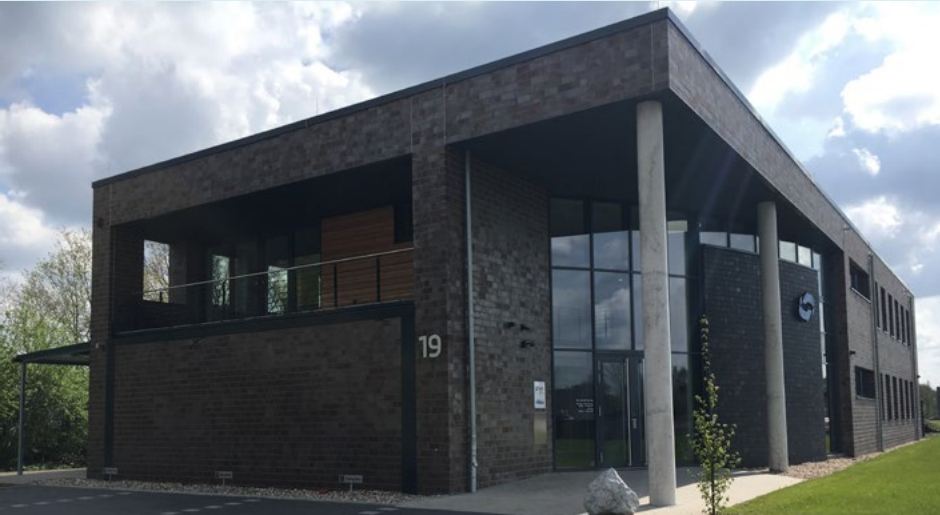
Die neue Geschäftsstelle der PVS Niedersachsen in Aurich
